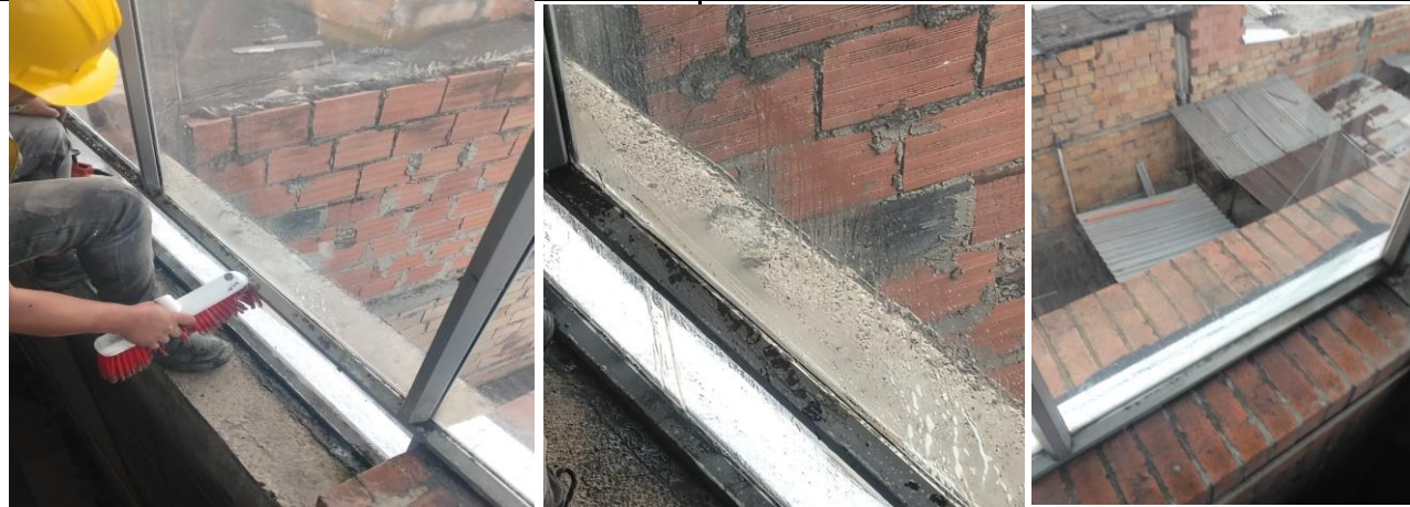
MANTENIMIENTO DE LA VENTANERIA EN DEL ÁREA DE LA SALA MINTIC Y EL TEATRINO ( CON LIMPIEZA- AJUSTE YA QUE ESTA SUELTA Y SELLADO CON SILICONA )
